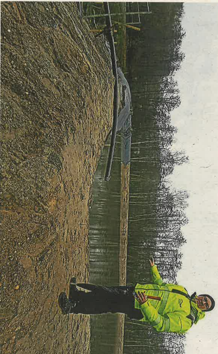
Thomas Schulz, Geschäftsführer des Schwalmverbands, steht an einem Spülfeld, in das Sedimente aus dem Vorbecken geleitet werden. Das Material trocknet dort und dient später der Ufergestaltung.
