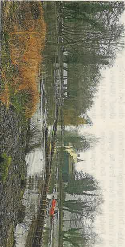
Ein kleines rotes Boot mit einem Saugrohr entfernt die Ablagerungen aus dem Vorbecken am Hariksee.
