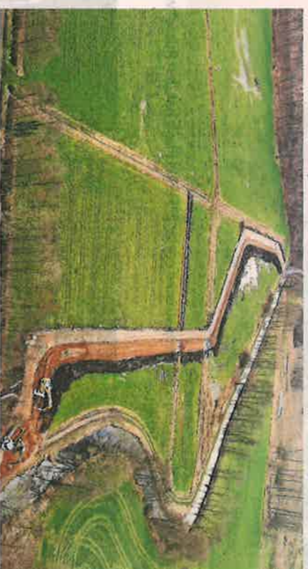
So sah die gesamte Baustelle am Schwalmdeich im Februar aus. Sattelschlepper hatten rund 4000 Tonnen Erde angeliefert.
