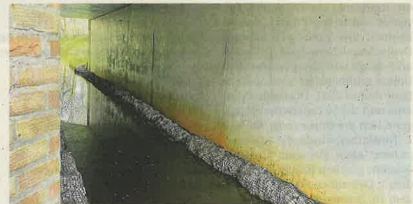
So sieht der neue sichere Weg für den Otter unter der Brücke am Laarer Bach aus. Ohne Bermen wäre sie für das wanderfreudige Tier schwer zu passieren.
