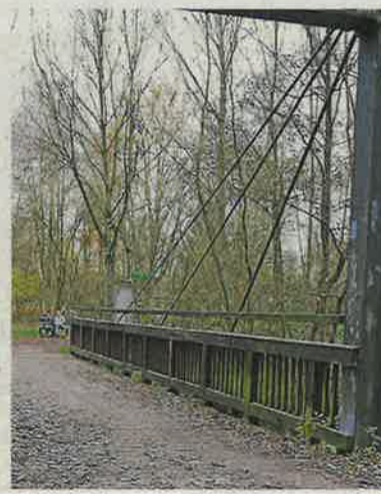
Die Holzbrücke am Deichweg nutzen viele für den Weg zur Gesamtschule.
