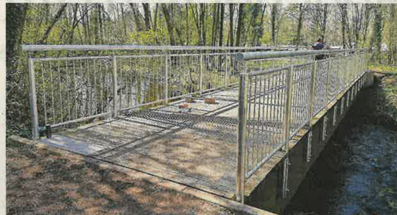
An der Brücke, die der Schwalmverband unterhält, wurde vor zwei Wochen das Geländer ausgetauscht. Sie ist die letzte ohne neuen Belag. FOTO: SCHWALMVERBAND
