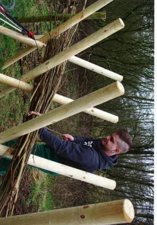
Zwischen den Böcken wird eine Faschinenwippe gebaut. Mit einer Schlaufe wird der gleichmäßige Durchmesser geprüft. Die Zweige werden mit Draht "verrödelt". So bezeichnet man das Aufdrehen der Drahtenden.
