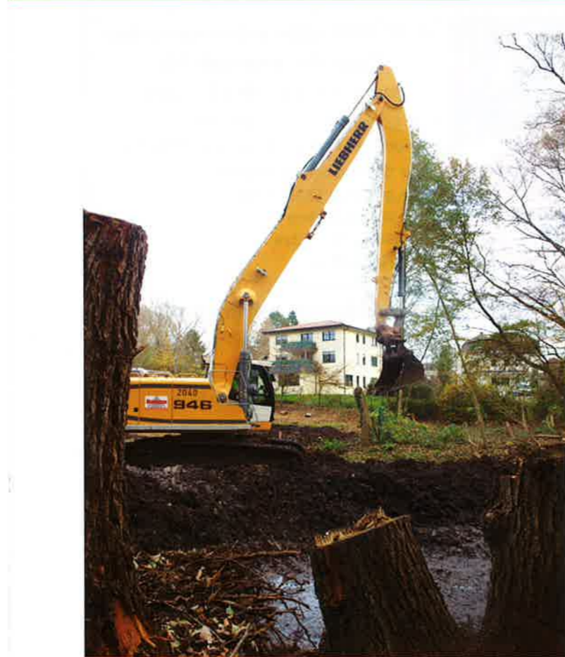
Der Baggerfahrer muss Maßarbeit leisten.
