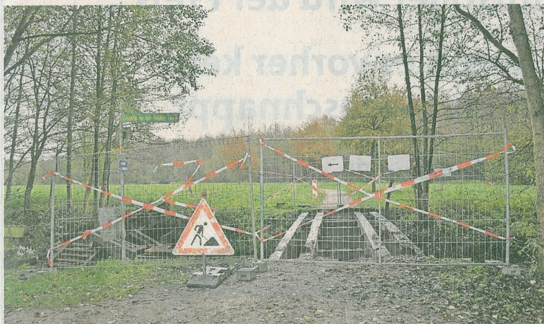
Gestern wurden die Tragbalken entfernt, heute wird ein Durchlass eingesetzt. Die Arbeiten sollen Ende der Woche abgeschlossen sein.
