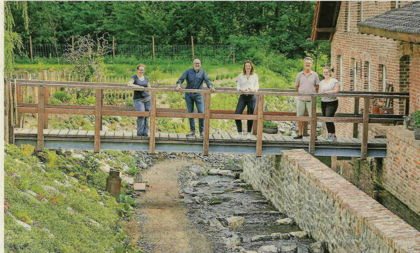
Sie freuen sich über die neue Fischtreppe an der Bischofsmühle in Wegberg-Watern: Roxana Rottig (von links) und Thomas Schulz vom Schwalm-Steiger von der Unteren Wasserbehörde (Kreis Heinsberg) sowie Norbert und Sarah Matzerath von der Eigentümerfamilie.
