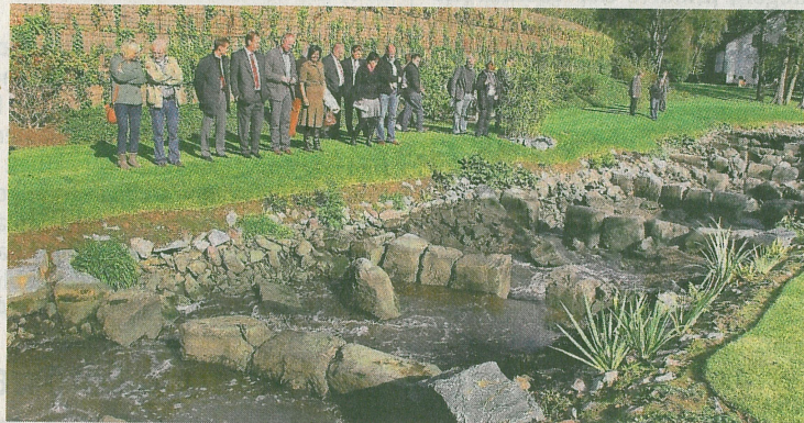
Gegenüber der Molzmühle (o.) wird an einer Fischtreppe gearbeitet (rechts ist die Schwalm zu erkennen). Ein Stück weiter ist an der Mühlrather Mühle (Hariksee) eine Fischtreppe (u.) fertiggestellt. RP-FOTO: LAASER/BUSCH SEN.
