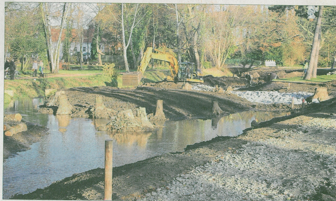
Die Bagger haben ihren Einsatz beendet. Die Mitarbeiter des Schwalmverbandes und der Firma ERWA sind mit den Erdarbeiten zügig vorangekommen. Die übrige Gestaltung des Geländes soll bis Ende März fertig sein. FOTO: NATURPARK
