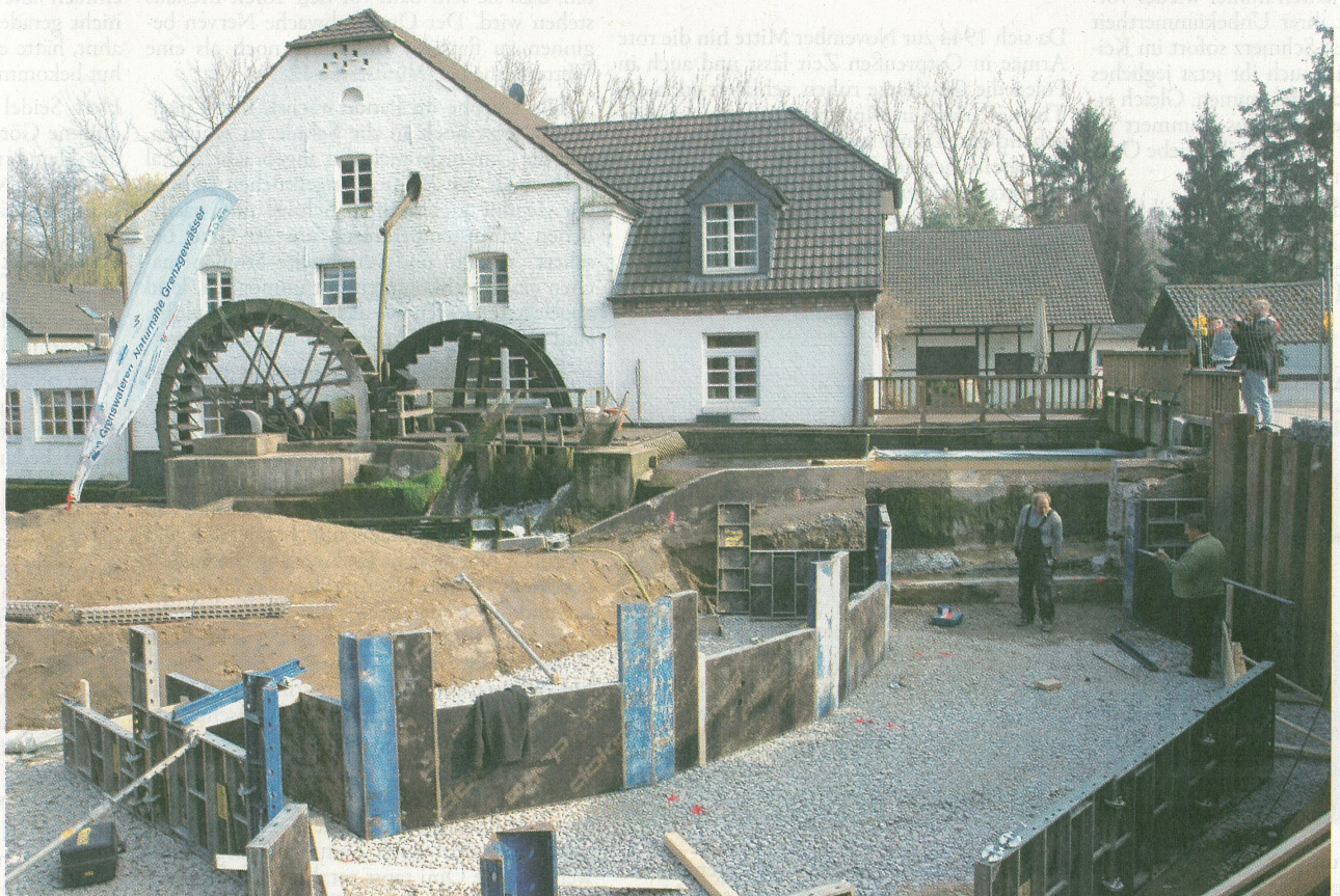
Die Arbeiten an der Mühlrather Mühle gehen voran. Hier wird zukünftig die neue Fischtreppe entstehen. Foto: Heike Ahlen
