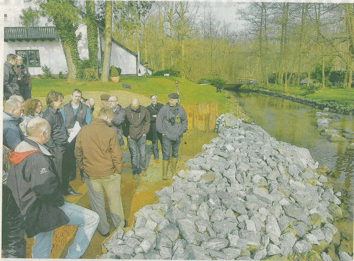
An der Mühlrather Mühle wird derzeit das höchste Wehr an der Schwalm mit einer Umgehung für die Fische versehen. Die können ab Ende April über 24 kleine Becken in den Hariksee und zurück gelangen. RP-FOTO: FRANZ-HEINRICH BUSCH
