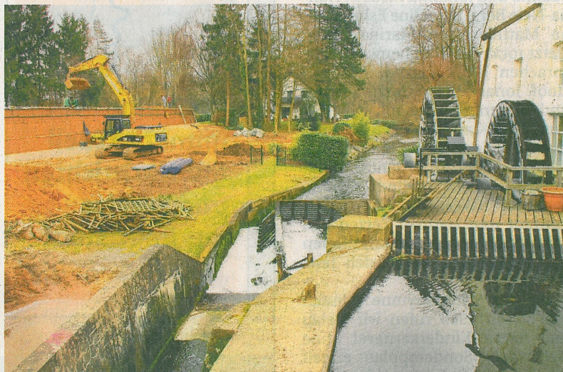
Zwischen der Straße und der Mühlrather Mühle ist neben der Fischtreppe auch ein Erdgabionen-Wall entstanden. Der wird noch begrünt. RP-FOTO: BUSCH
