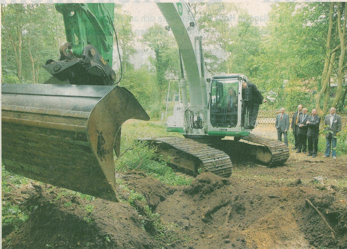
Keine Angst vor großem Gerät zeigte gestern Umweltminister Eckhard Uhlenberg : Im Führerhaus des Raupenbaggers dirigierte er die Riesenschaufel beim Spatenstich für die Fischaufstiegsanlage an der Lüttelforster Mühle. RP-FOTO: BUSCH
