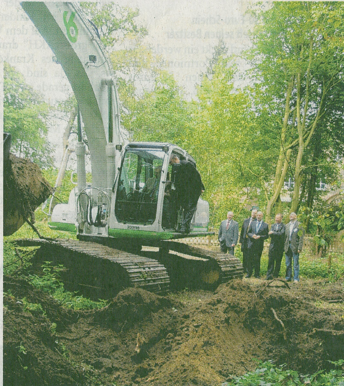
An der Lüttelforster Mühle wird eine Fisch-Aufstiegsanlage entstehen. Zum ersten Spatenstich kam Landes-Umweltminister Eckhard Uhlenberg. Foto: Ahlen
