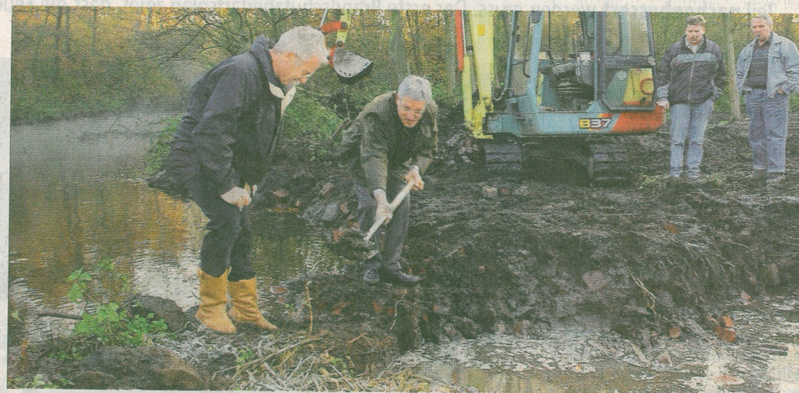
Der Durchstich an der Brügger Vennmühle Ende 2003 gehörte zu vielfältigen Renaturierungsarbeiten. Der Schwalmverband will die vom Menschen eingezwängte Schwalm wieder natürlicher fließen lassen. RP-ARCHIVFOTO: BUSCH
